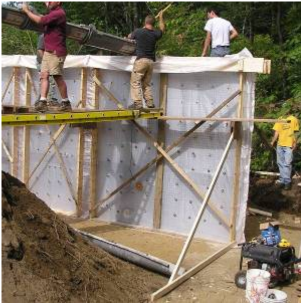
Fig. 10. Concrete Pour
