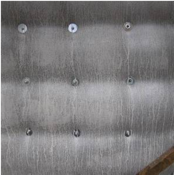
Fig. 17. Completed Concrete Pour
