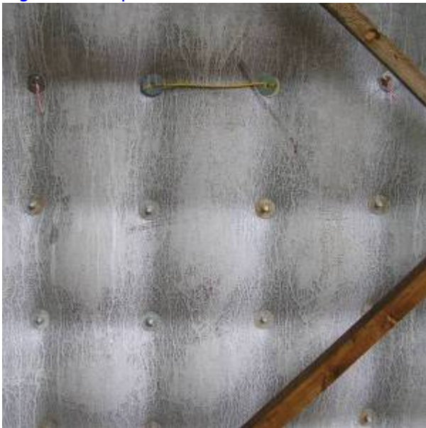
Completed Concrete Pour
